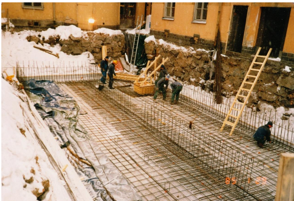
Gjutning av skyddsrummet under 16A-gården. Gårdshuset till höger i bilden. Foto Olev Nöu
