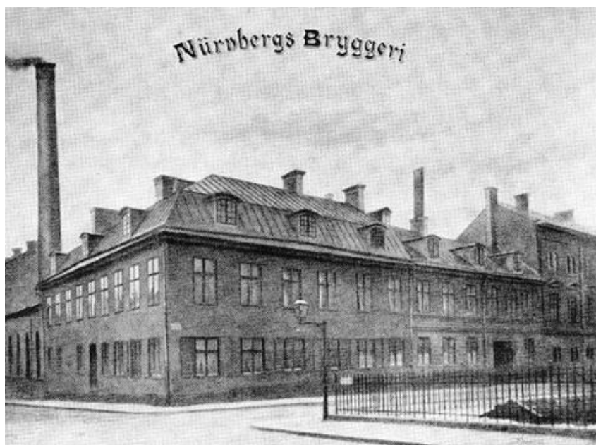
Ångpannehuset med skorstenen. Foto från Brings bok (uppges vara taget på 1880-talet vilket måste vara en feldatering).
