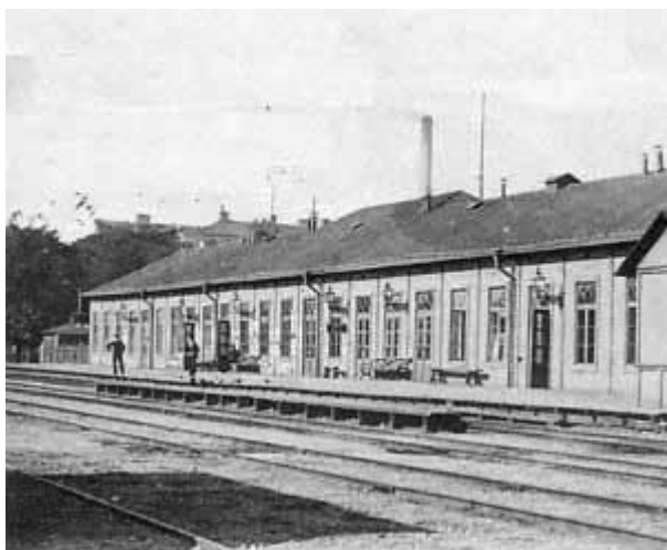
Södra Station, ursprungliga stationshuset, bild från 1800-talet. Källa Wikipedia
